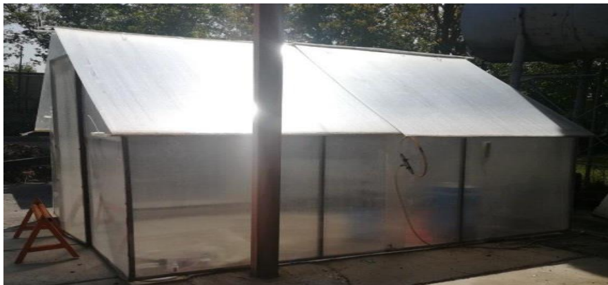
شکل ۱- سازه گلخانه تحقیقاتی ساخته شده در گروه مهندسی بیوسیستم دانشگاه فردوسی مشهد
