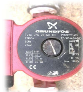
شکل ۷. پمپ گردشی GRUNDFOS مدل UPS ۲۵-۶۰
