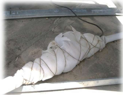
شکل ۸. پمپ گردشی پیچیده شده در غلاف عایق جهت جلوگیری از یخ زدن
