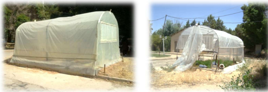
شکل ۱. باز کردن پوشش قبلی گلخانه شکل ۲. گلخانه بعد از نصب پوشش بیرون
