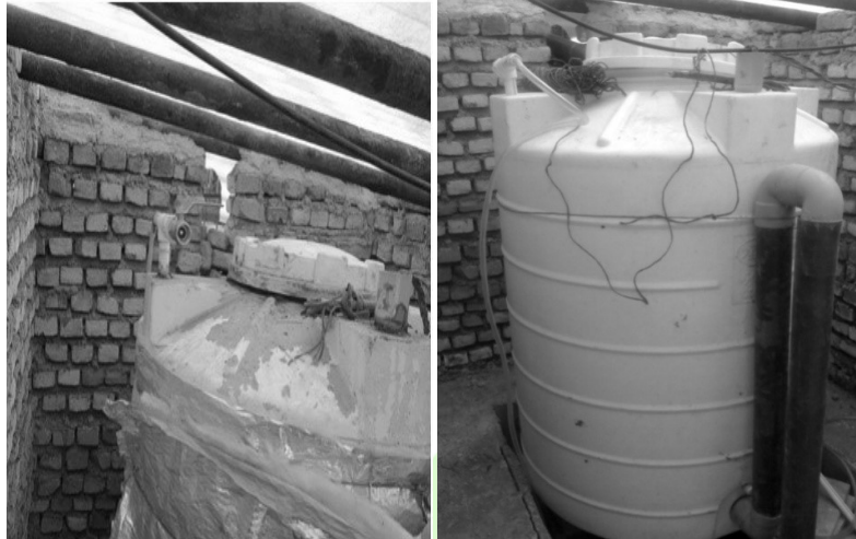
شکل ۱- الف- مخزن هضم پلی اتیلنی ب- پشم شیشه به عنوان عایق حرارتی
