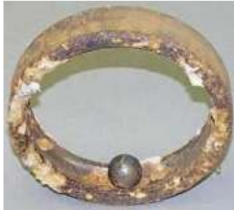
شکل ۳- فرسایش ناشی از نفوذ آب ( بهادری یکتا، ۱۳۸۲).
