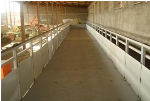
شکل ۱- کانال ساخته شده قبل از خاکریزی و نصب حامل و سایر اجزاء سویل بین
