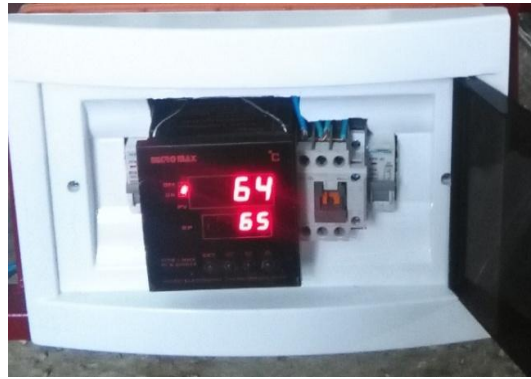
شکل ۲. مدار راه انداز دستگاه با کنترل دمای محلول و المنت
