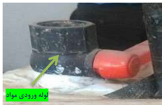
شکل ۳- لوله ورودی مواد به مخزن هاضم
