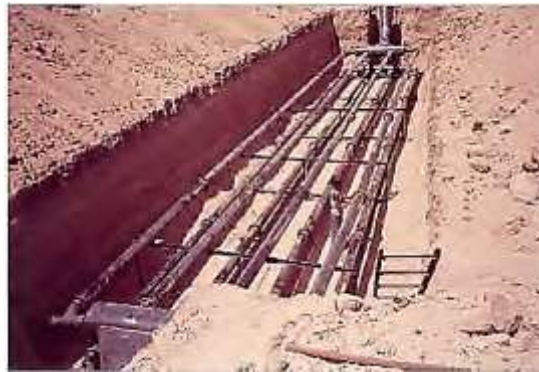
Fig7. Pre covering شکل ۷. قبل از پوشش
