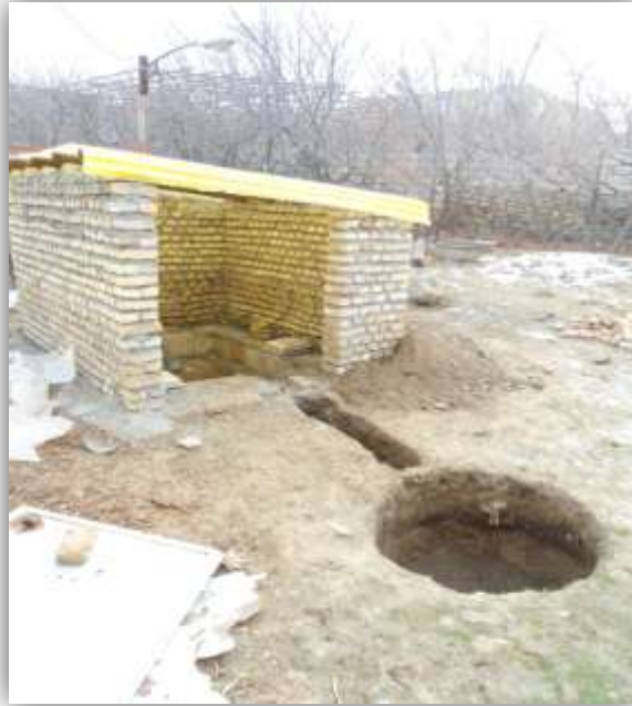
تصویر 1- ساخت اتاقک عایق
